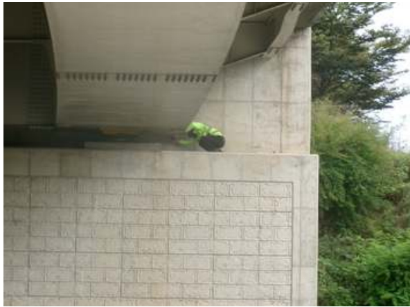
도보를 이용한 부재치수 현장측정
